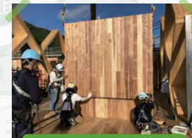
銘建工業新社屋の 木躯体工事の様子
